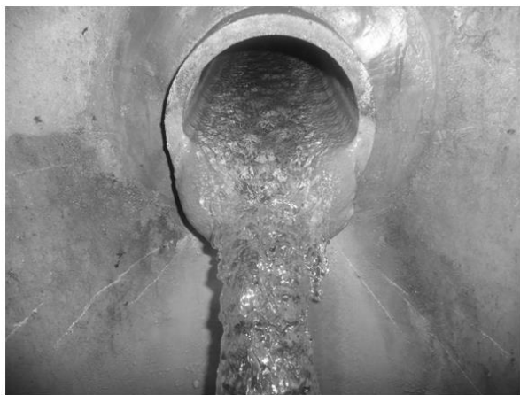
Foto 4: Karbonátový inkrust vo vtokovom potrubí šachty S64
