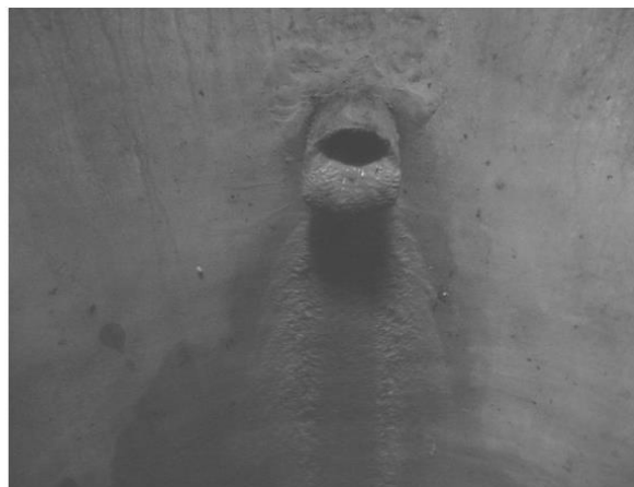
Foto 5: Výrazné zmenšenie prierezu potrubia v dôsledku inkrustácie (S117)
