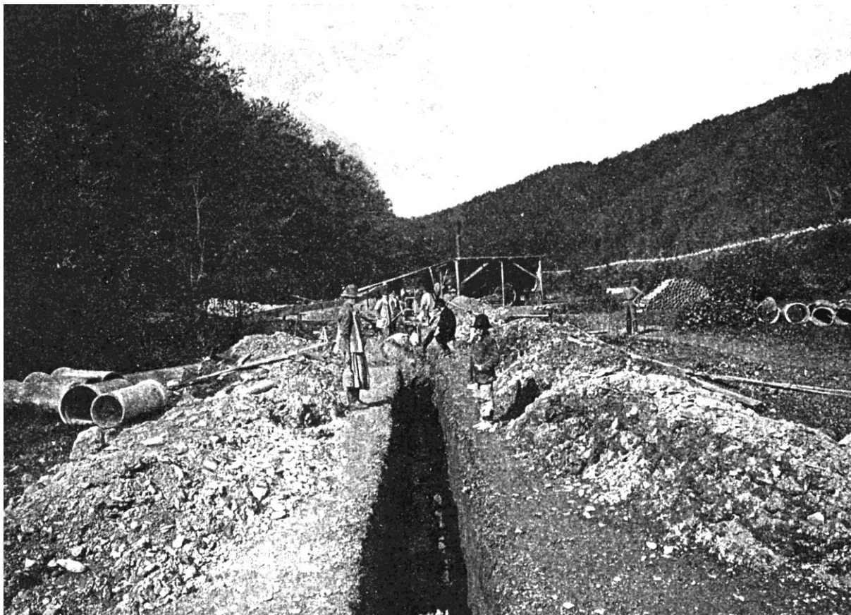
Foto 1: Dobová fotografia z výkopových prác prvého košického vodovodu
