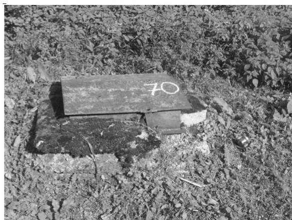
Foto 7: Príklad poškodenia betónového záhlavia. Šachta S132
