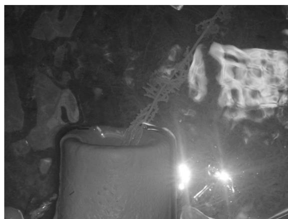
Foto 3: Karbonátový krust na odtokovom potrubí v šachte S6
