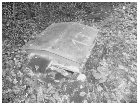
Foto 6: Príklad poškodenia betónového záhlavia. Šachta S20
