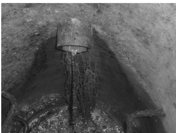
Foto 2: Korene vo vtokovom potrubí šachty S6
